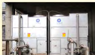
河北钢铁集团迁安联合鑫达钢铁有限公司 变频器冷却
