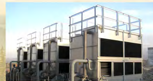
河北钢铁集团迁安联合鑫达钢铁有限公司 变频器冷却
